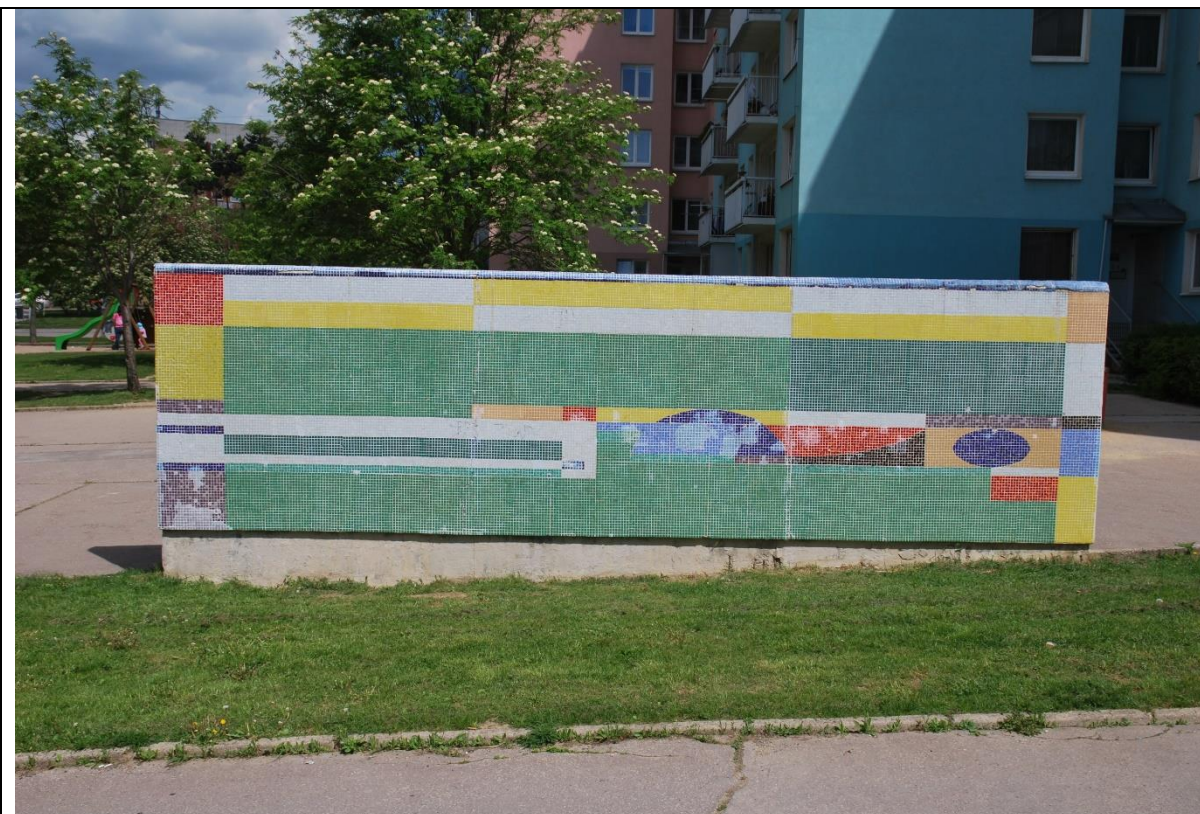
Stav před restaurováním, jižní stěna
