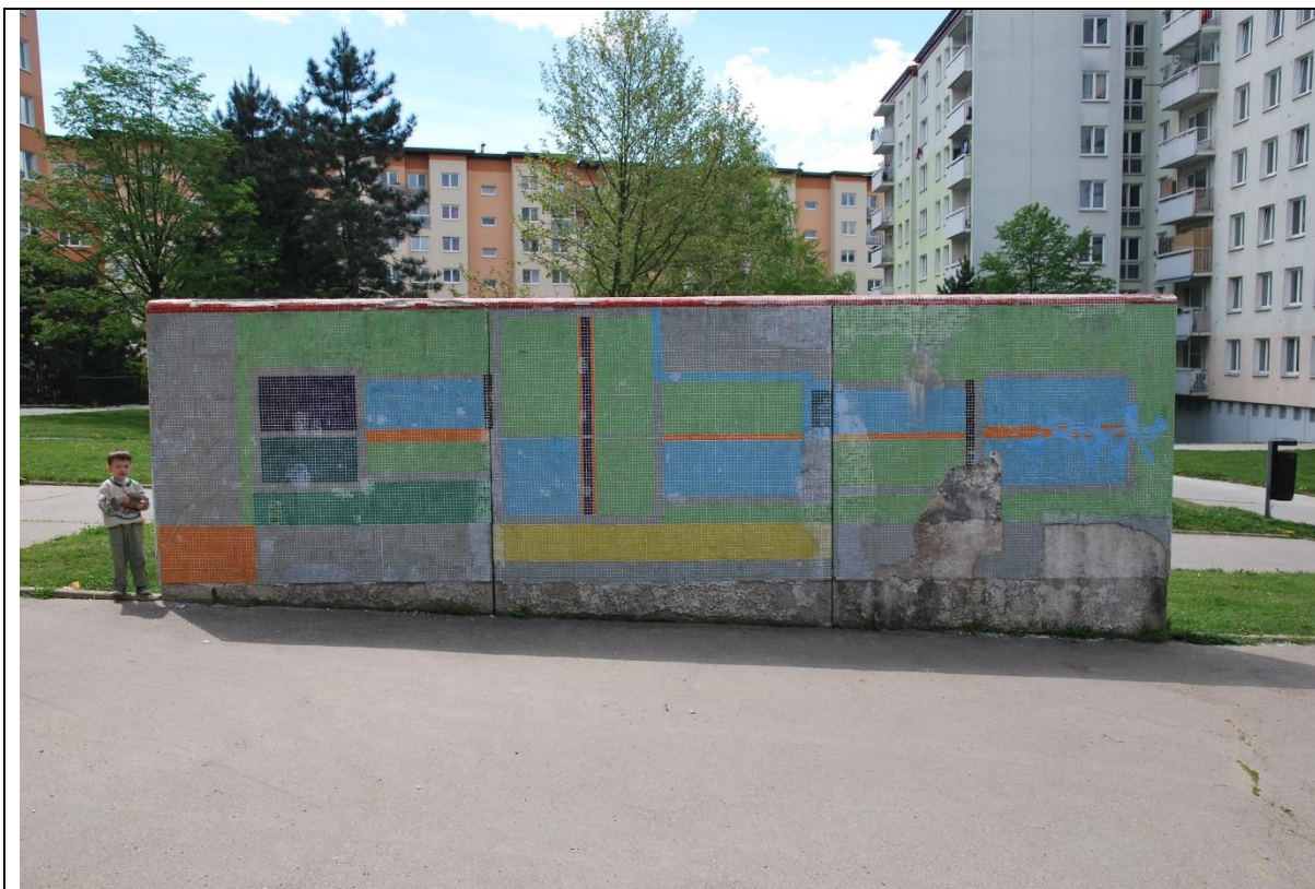
Stav před restaurováním, severní stěna
