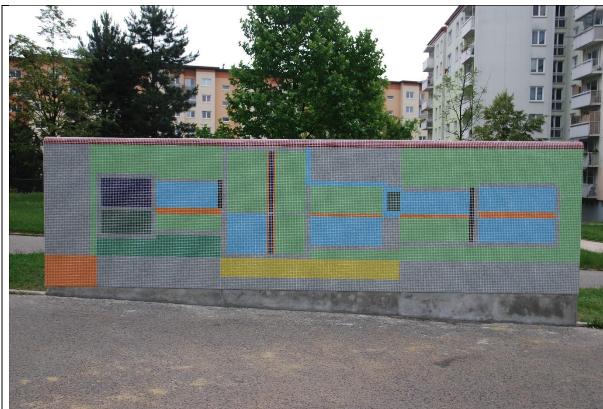
Stav po restaurování, severní stěna
