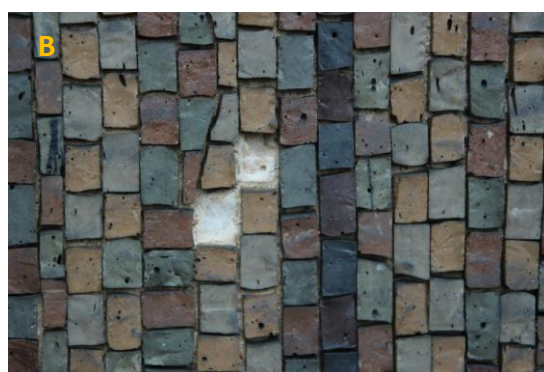
Obr. 3 Kostky štípaného mozaikového skla importované za zahraničí. A) Detail výzdoby průčelí kaple Panny Marie Bolestné, Praha-Hlubočepy, Viktor Förster, 1903, velikost pohledové strany kostek je cca mozaiky 10 x 15 mm. B) Kostky z mozaiky sv. Cyrila umístěné na bazilice sv. Petra a Pavla na Vyšehradě; 1903, realizace Königlich Bayerischen Mosaik-Hofkunstanstalt. Foto I. Kučerová a M. Kněžů Knížová
