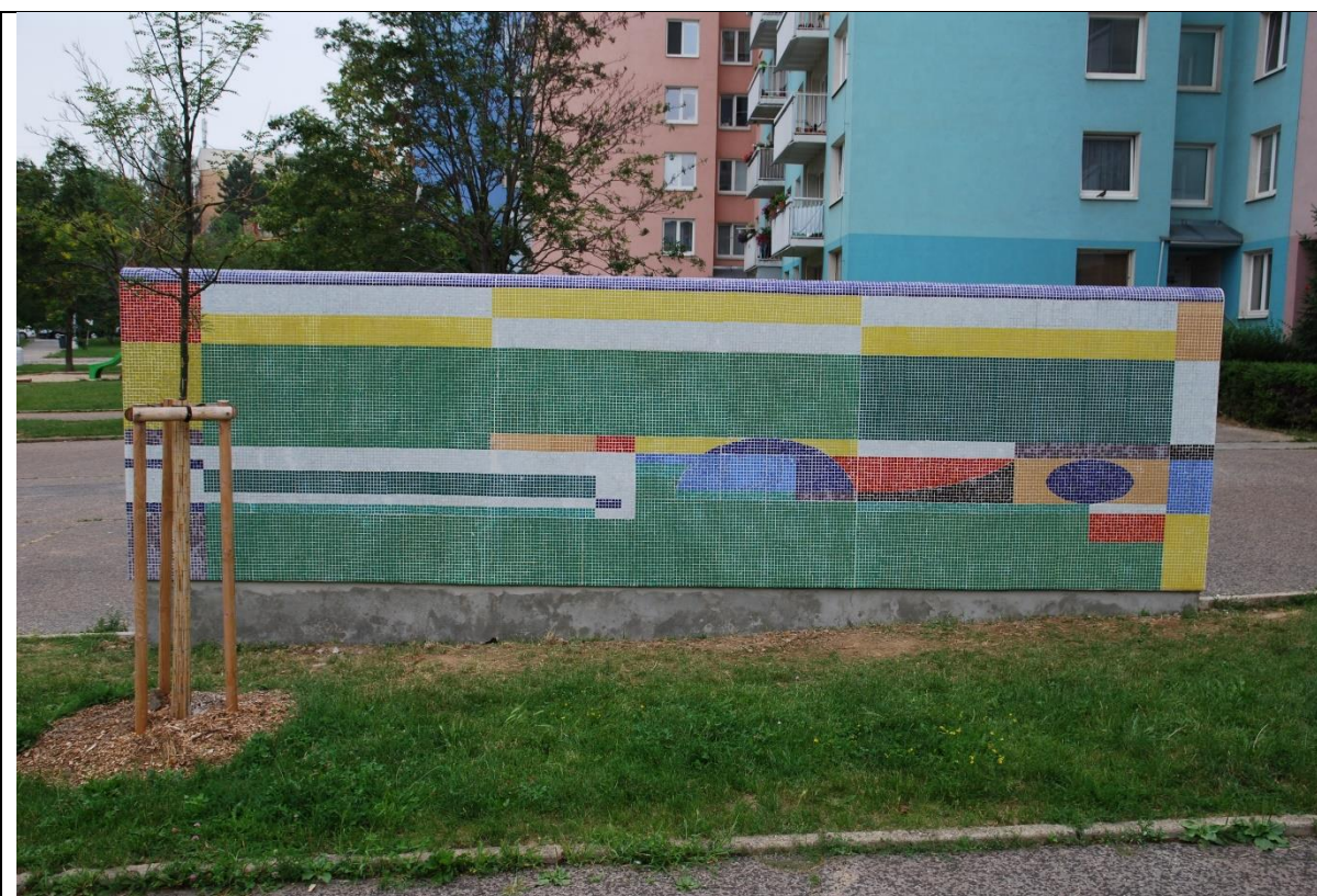
Stav po restaurování, jižní stěna
