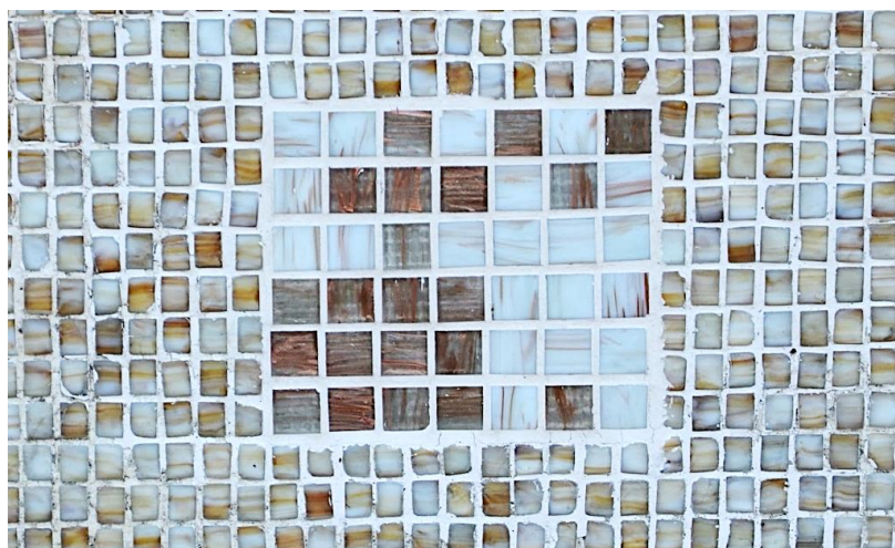
Obr. 6. Oprava obkladu jiným typem skleněné mozaiky. Foto I. Kučerová
