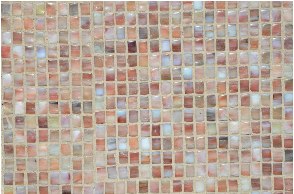
Obklad budovy gymnázia v Kladně z rotačně mačkané mozaiky. Foto I. Kučerová
