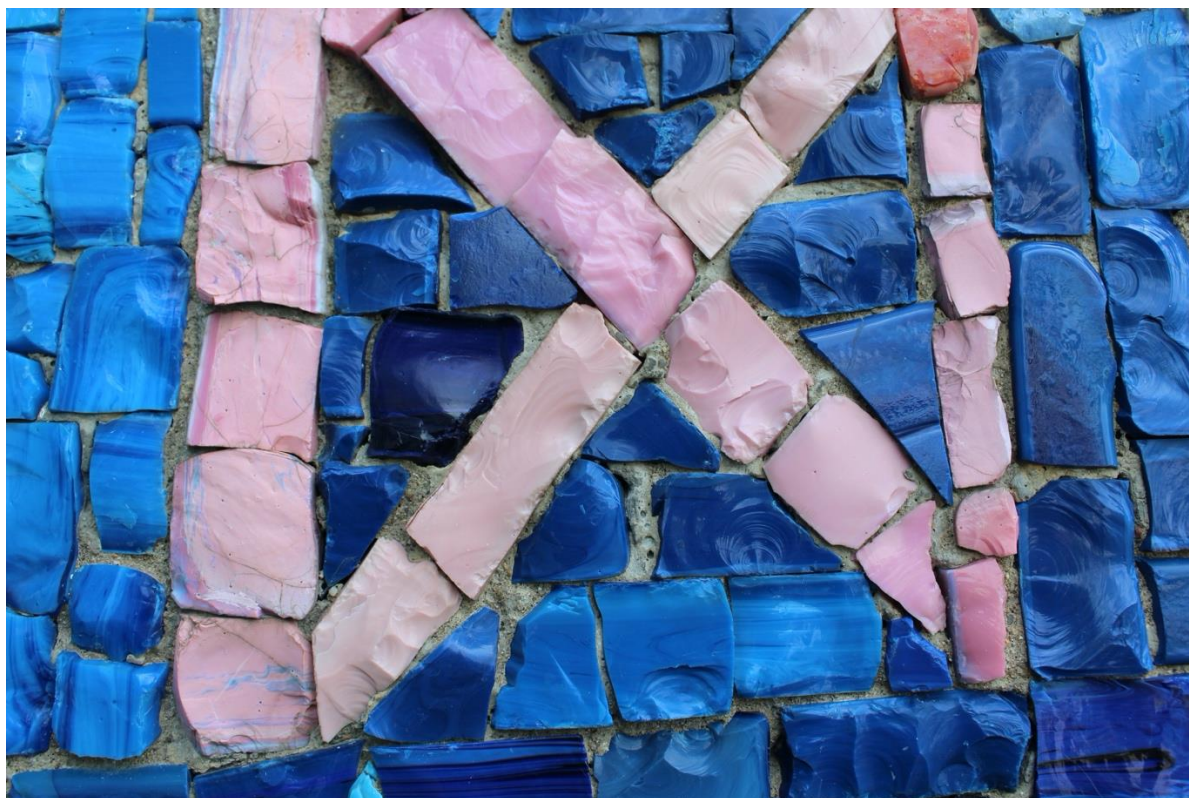
Obr. 15 Detail mozaiky Miroslava Houry Oslava Kosmonautiky, Ústí nad Labem, 1981-83. Mozaika je sestavena ze štípaného mozaikového skla, které vykazuje tzv. lasturovitý lom. Ten je dobře patrný např. na velké modré kostce v pravé spodní části fotografie. Světlemodré kostky obsahují šlíry. Foto M. Kněžů Knížová
