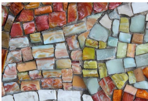
Obr 2. Detail abstraktní mozaiky Antonína Procházky, Chlumec, 1976. Mozaika je vysázena z kostek různé velikosti, mozaikové sklo obsahuje ve hmotě značné množství šlír, tj. sklo je ve hmotě nestejně zbarveno (např. bílá kostka s okrovými šmouhami nebo červená kostka s bílými šmouhami). Foto M. Kněžů Knížová
